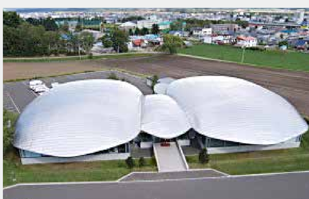
シンボリックなドーム屋根等の変形形状まで施工可能
